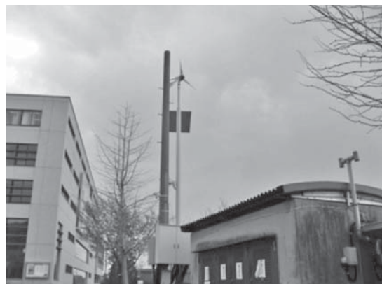
写真5 風力と太陽光の融合発電 （ハイブリッド）による街灯
