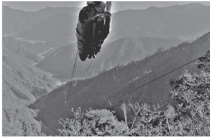
〔図-8〕 熊野古道の傍らで稼働中の林用索道 (昭和35年12月27日 小雲取越の筆者撮影)
