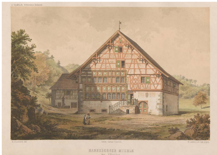
図8：スイスのハーフティンバー建築（独：Fachwerkhaus）の一例として挙げられたエフレティコン Effretikon 近くにあるマンネンベルク Mannenberg の水車小屋（エルンスト・グラートパッハ『ドイツの木造建築と比較してみるスイス各州の木造様式の違い』1882年より、チューリヒ工科大学図書館蔵）
