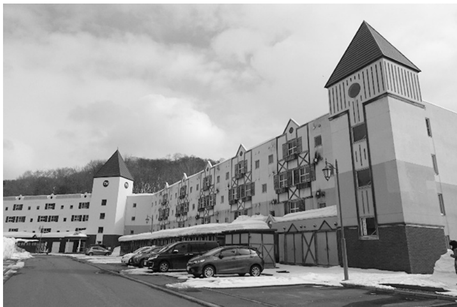
図12 歌志内の東光地区の公営住宅「TH」（2021年3月筆者撮影）
